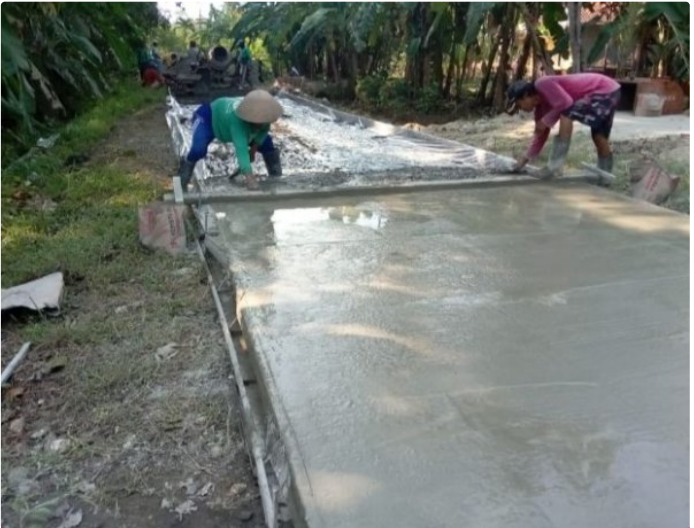
Pembangunan insfrastruktur Jalan Rabat Beton di Desa Rejamulya
